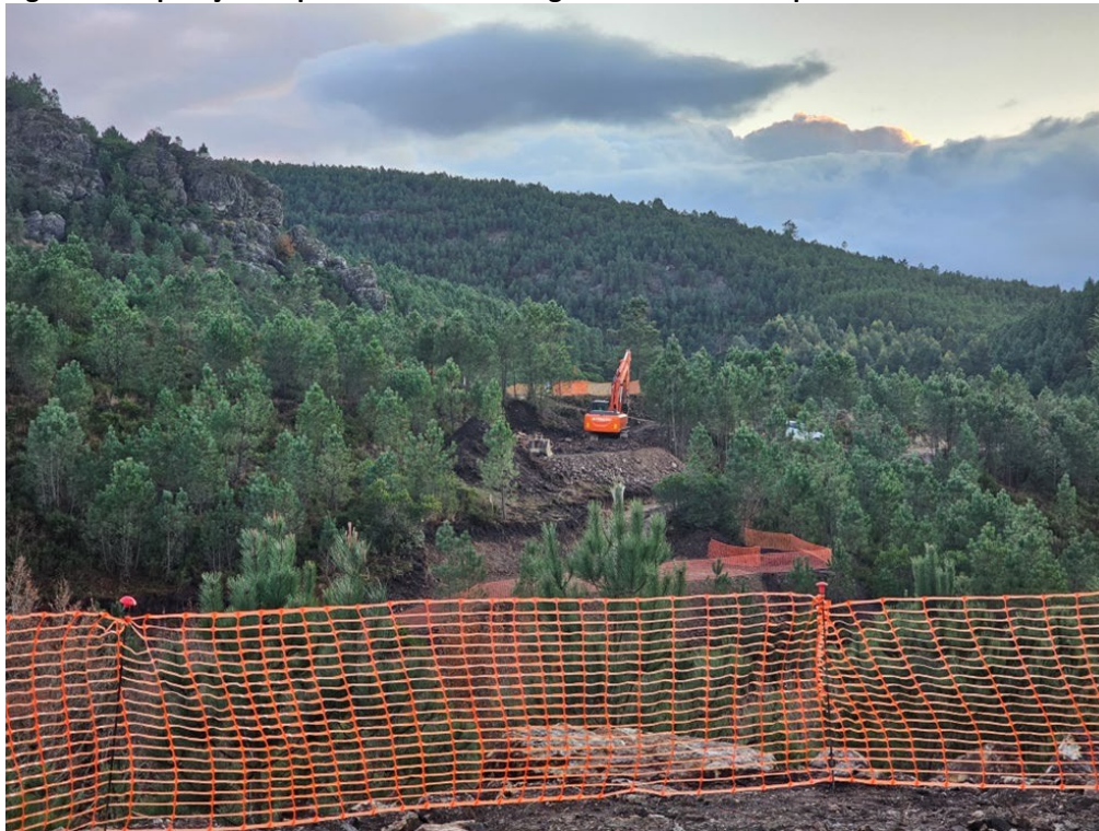
Figura 1: Preparação da plataforma de sondagem em curso no depósito do Pinheiro
